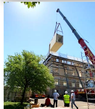
Chantier bÖArchitectes associés
