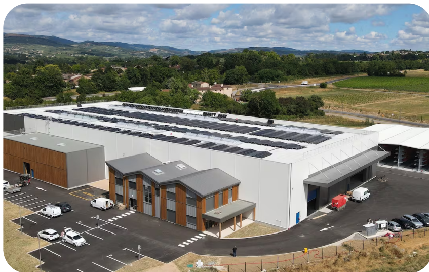
Le nouveau site de Vouillon à Mâcon porte les surfaces de bureaux et d'ateliers de 2 000 à 5 500 m 2 et accueille les nouvelles lignes de fabrication hors site. Photo : entreprise Vouillon
