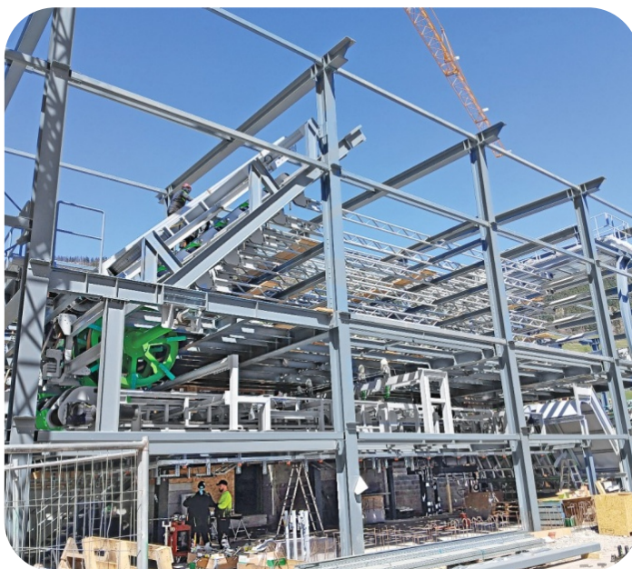
Assemblage à Innichen : les différents modules de l'installation, préfabriqués à Friesach, sont en cours de montage chez Watschinger Holzindustrie. © Springer
