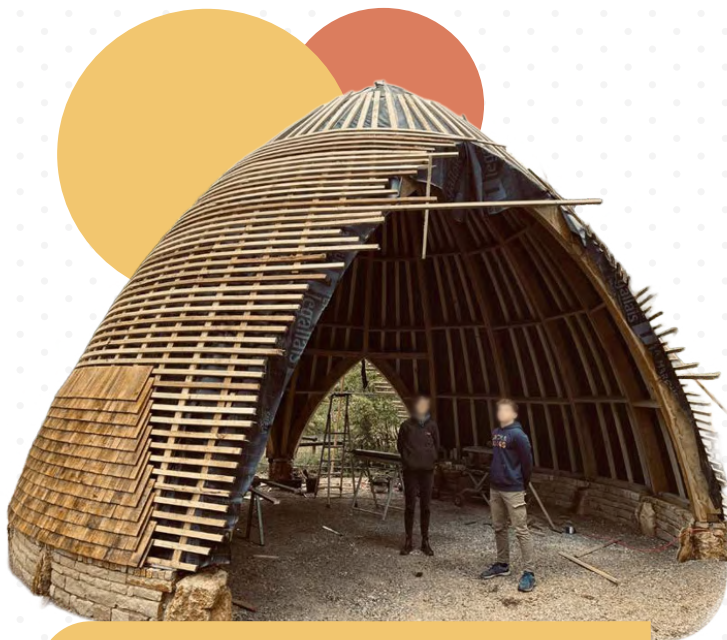
Porte de cœur du Parc national de forêts en cours de construction, Atelier Correia Photo Parc national de forêts - FX Delerce
