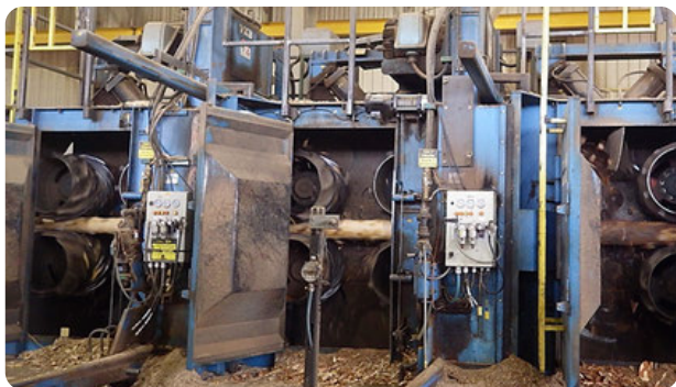
Contrôle thermique des billes lors de l'écorçage - Photo : FPInnovations
