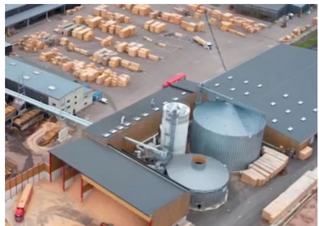
L'usine de granulés de Brenil Énergie Renouvelables - Photo : Fruytier Group
