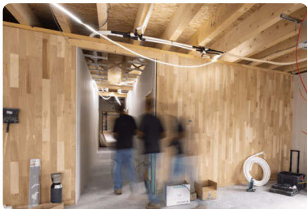
Panneau CLT en chêne - Photo : Bâtichêne
