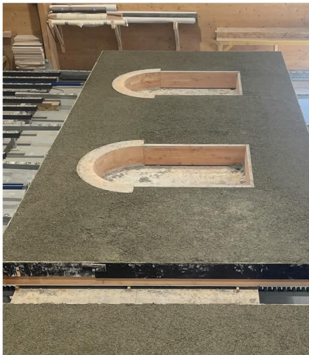
Mur en cours de fabrication à l'atelier Wall'up : béton de chanvre en cours de séchage • 2023 • ©Wall'up
