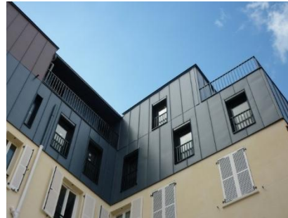
Surélévation ossature bois DTU31.2 sur béton (réhab/neuf)
